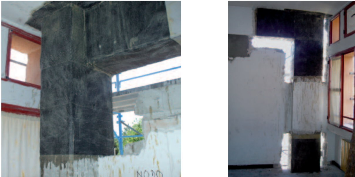
Fig. 1. Intervento di rafforzamento locale di nodi in c.a.
